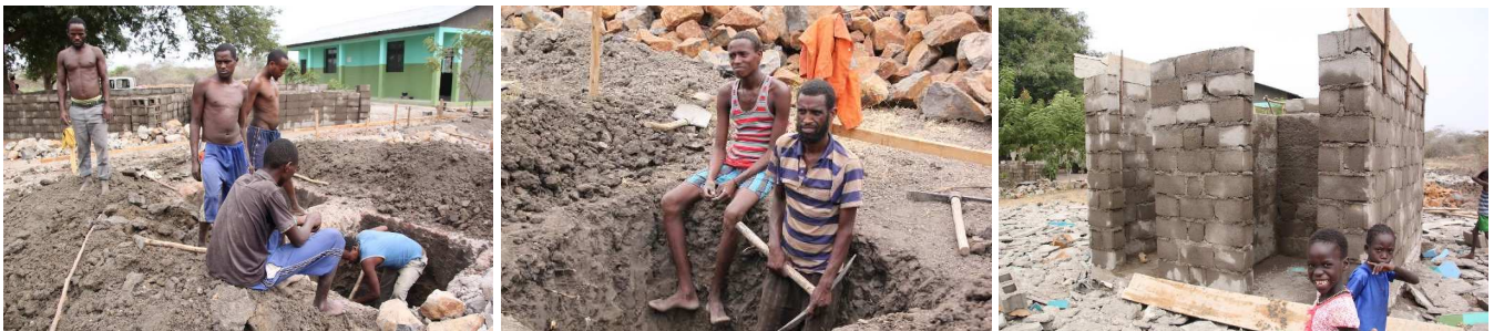
Die Bauarbeiten haben begonnen, im Hintergrund das Vorgängergebäude, zukünftig als Bürokomplex genutzt
