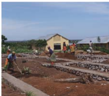
Erste Schritte zum Fundament
