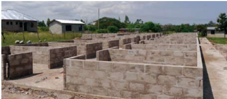
Grundmauern auf fertigem Fundament
